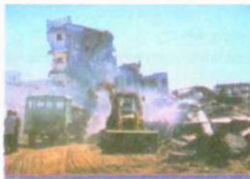
Іл. 38.6. Аварійно-відновлювальні роботи після землетрусу
