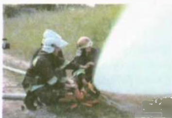
Іл. 38.3. Установлення водяної завіси тонко розпиленою водою
