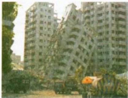
Іл. 30.1. Наслідки землетрусу
